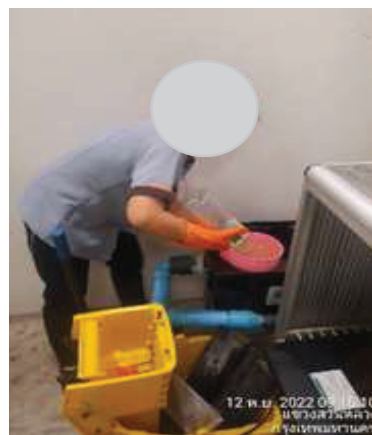
ภาพถ่ายที่ 2.2-12 แม่บ้านตักไขมันออกจาก Grease Trap
