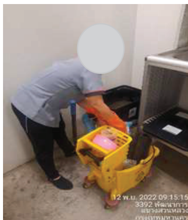
ภาพถ่ายที่ 2.2-12 แม่บ้านตักไขมันออกจาก Grease Trap
